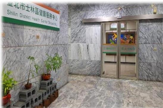
圖16. 除樓梯廁所等處扶手止滑設置，另將單片進出推門改為雙開電動門
