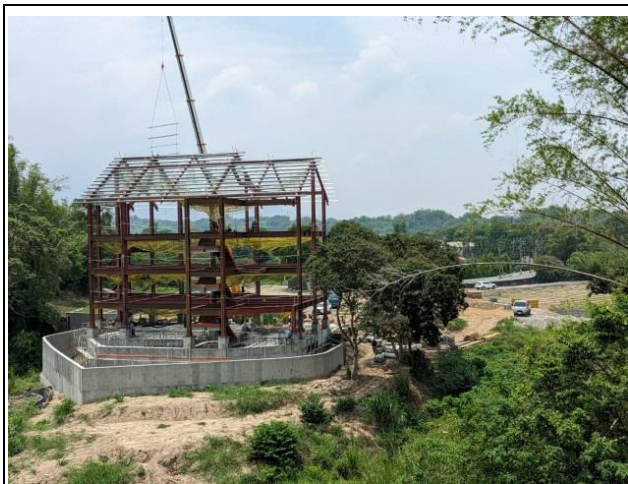
附近興建殯葬設施開挖山坡整地打地基之狀況
