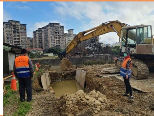
(圖 3-1-5)颱風豪雨前會特別到施工處巡視狀況
