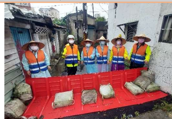
(圖 4-3-6)防水檔板實際運用情形
