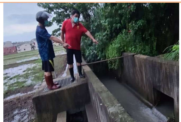
(圖 3-1-3)110 年 8 月自主巡查，發現金蘭醬油廠溝排入更寮腳造成淹水
