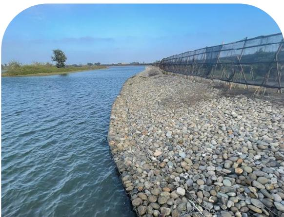
沖蝕邊坡採砌排塊石生態工法，增加生物棲息孔隙，降低環境衝擊
