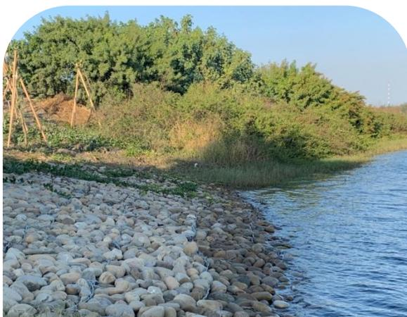
迎風面採石籠護坡，其餘被風面之護岸仍保留原有植被，提供多樣生物棲地
