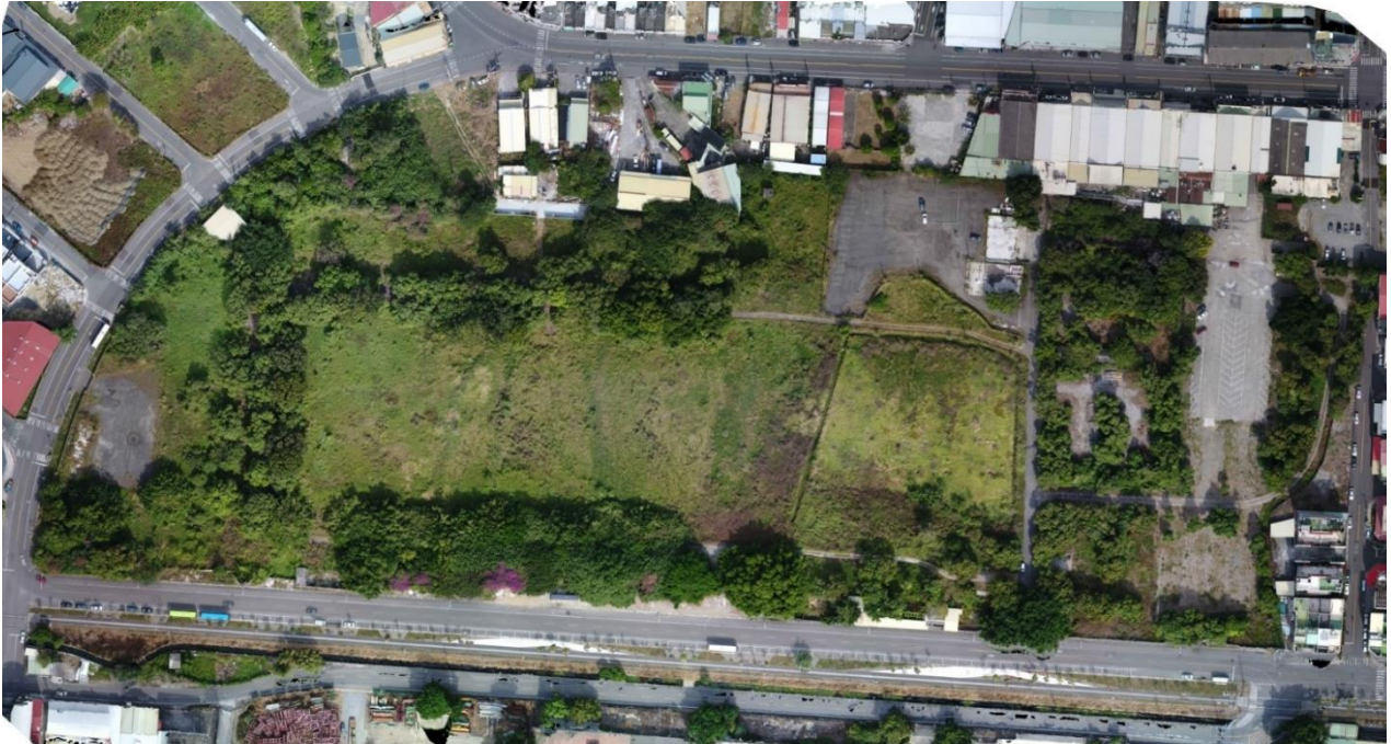
施工前 全區空拍照 106 年 12 月
