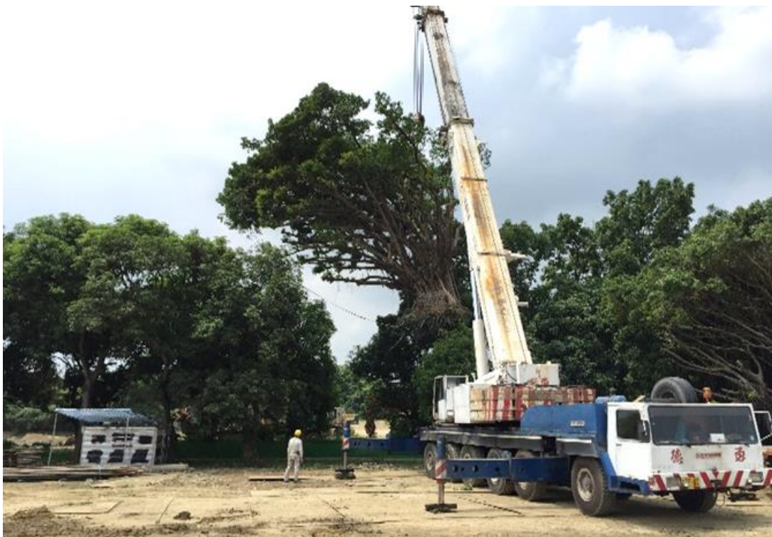
4.起吊、穿越綠色隧道
