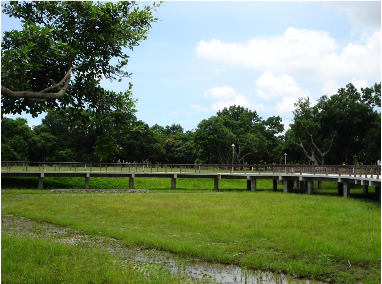
公園(乾式滯洪池)
