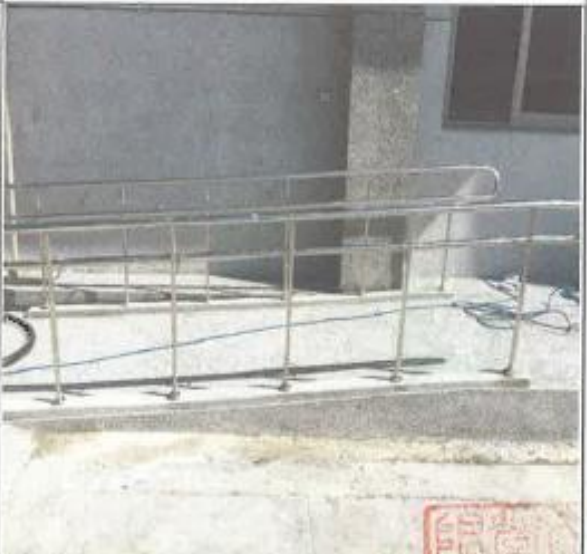
無障礙坡道改善後
