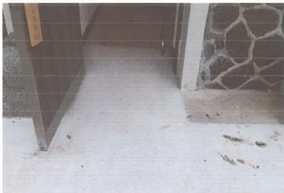
108.01.25 801 房入口坡道改善後
