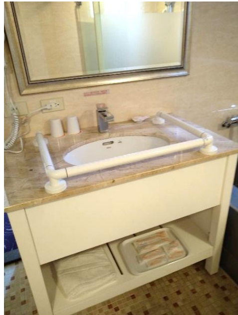
無障礙客房 1 間, 客房設置 2 處求助鈴. 客房內廁所盥洗室馬桶 2 側設置有扶手及 2 處求助鈴, 淋浴間牆壁設置垂直及水平扶手, 洗手台已設置扶手。
