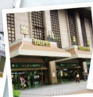
車站、旅客等候室
