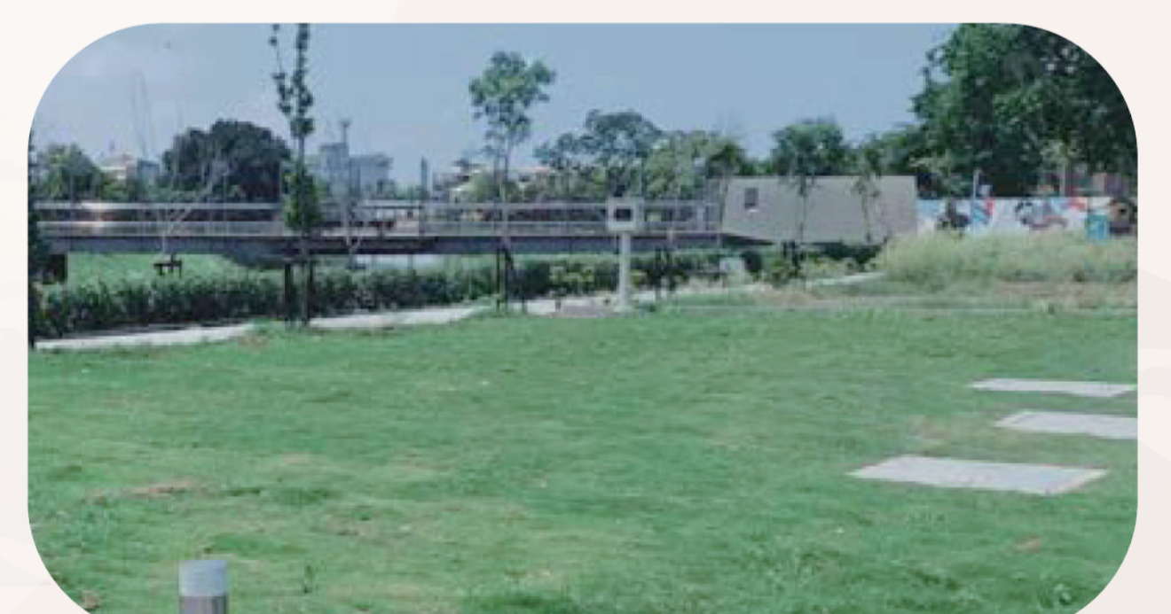
信義路合併式淨化槽淨水廠地下化設計 每日處理 50 噸 污水
