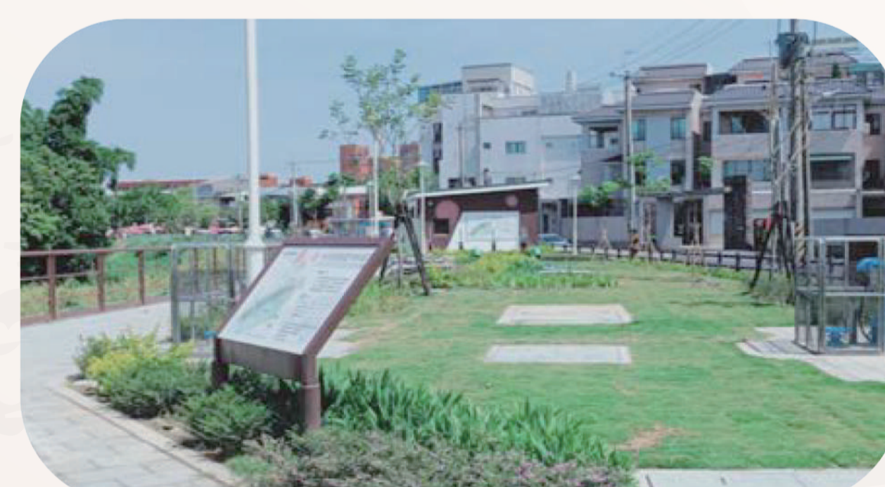
土庫路礮間式淨水廠 每日處理 730 噸 污水
