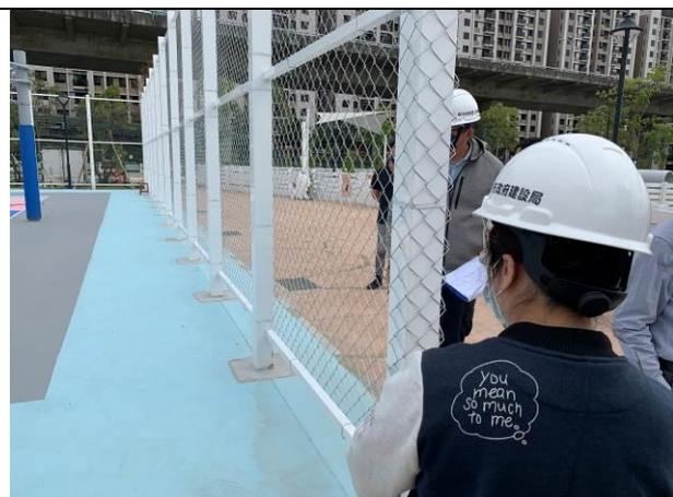
施工中：籃球場圍籬、遮陽棚支柱、寵物區圍籬支柱採用回收鋼材做為立柱
