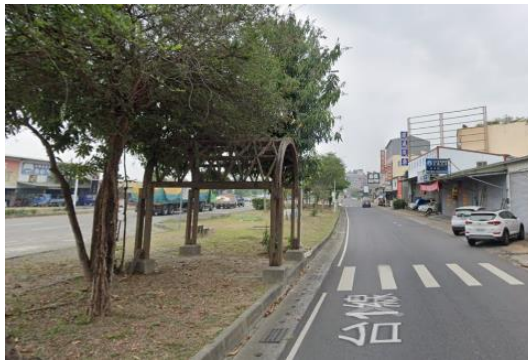
無障礙候車空間改善前
