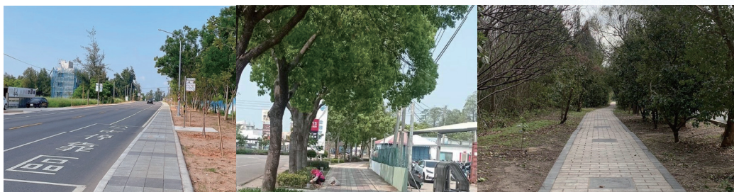
▲圖32 – 本縣無障礙道路改善及美化情形
