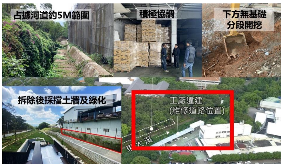
圖 7 還地於河-拆除東大溪河道內 2 處違建
