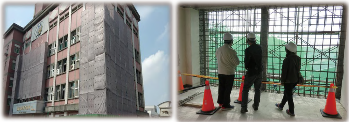
圖 3-30 規劃辦理廳舍補強工程
