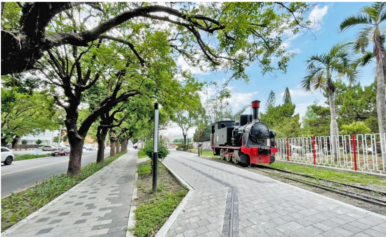
圖 28 第一期工程完工影像
