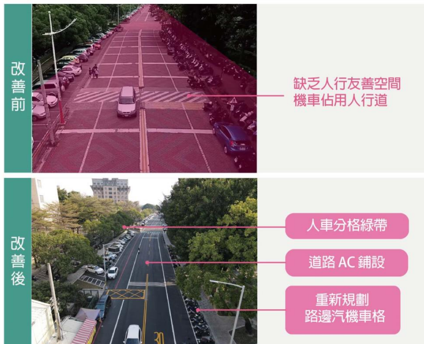
圖 17 改善前後影像-AC 道路鋪設
