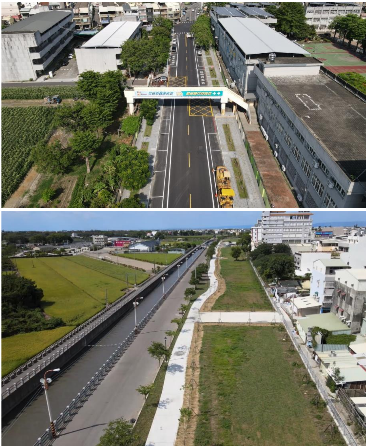
圖 32 第三期工程完工影像
